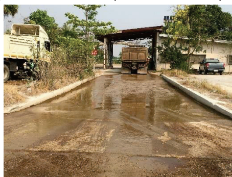
รูปที่ 2-19: ลานล้างล้อรถบรรทุก
