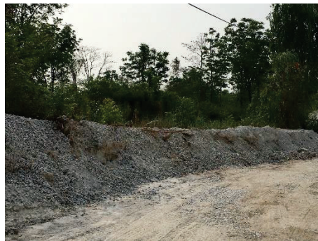
รูปที่ 2-20: คุระบายน้ำและคันทำนบดินตามแนวเขตโรงโม่หิน
